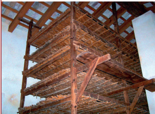
Estructures de fusta i canyís per a la cria del cuc de seda conservades a l'andana de l'Alqueria de Félix
