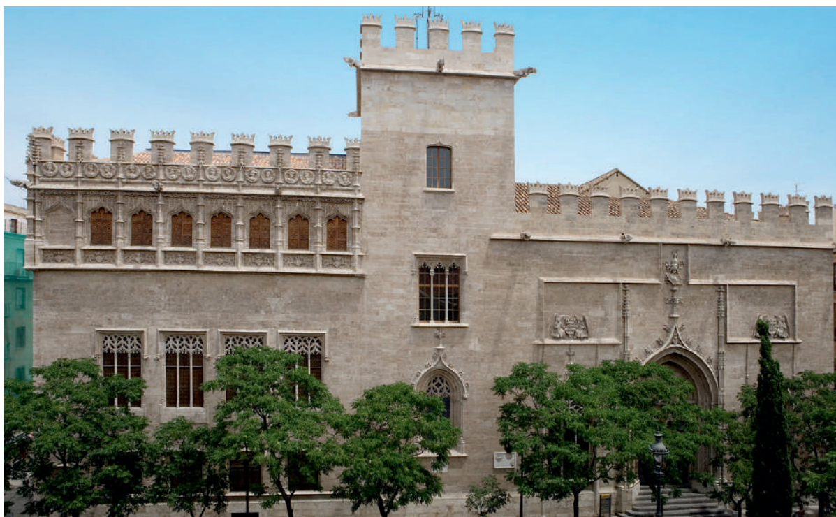
Facciata principale della Loggia della Seta.
