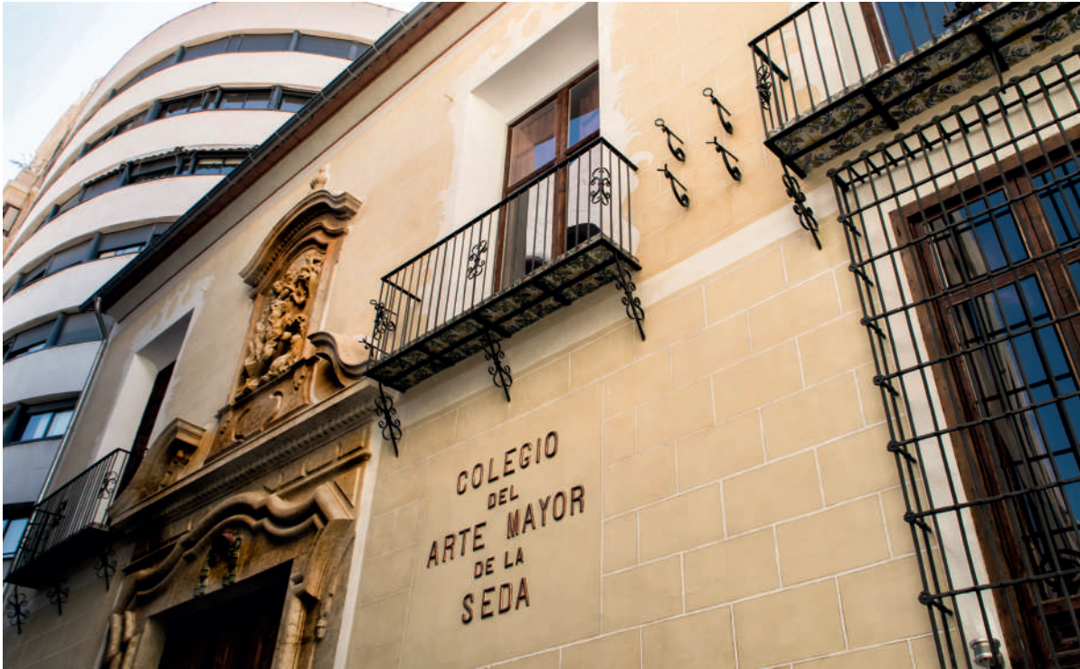
Facciata del Collegio della Grande Arte della Seta.
